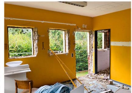
Vieles ist bereits ausgebaut
