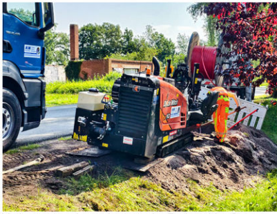
Verlegung von Leerrohren an der Rodewalder Straße
