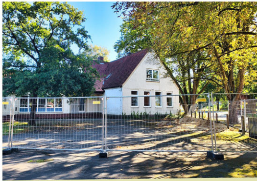
Vor dem Abriss, ein Bauzaun sichert das Gelände
